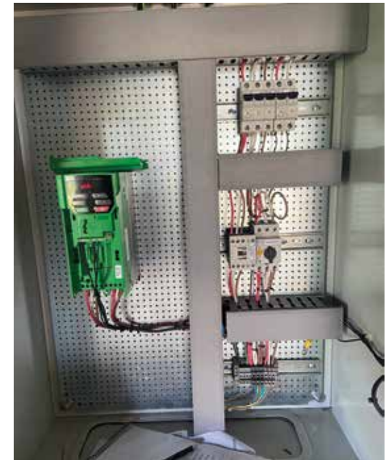
Imagen 1. Variador de velocidad o de frecuencia
